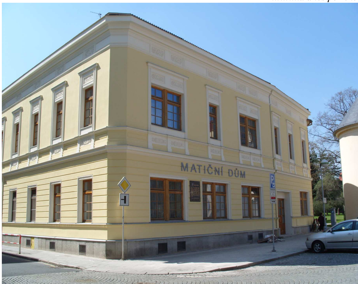
.....a dnes po rekonstrukci
